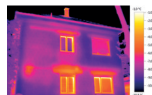
Image thermique avec testo ScaleAssist
