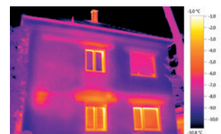
Warmtebeeld met testo ScaleAssist
